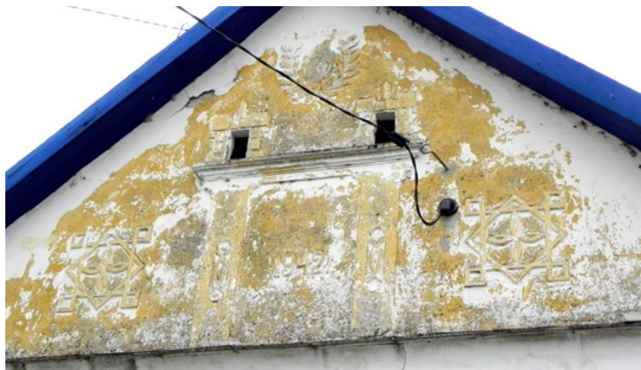
5. kép Fehér meszelés alól kilátszó sárga homlokzat 1942-es évszámmal (Szakmár, 2011, saját fotó)
